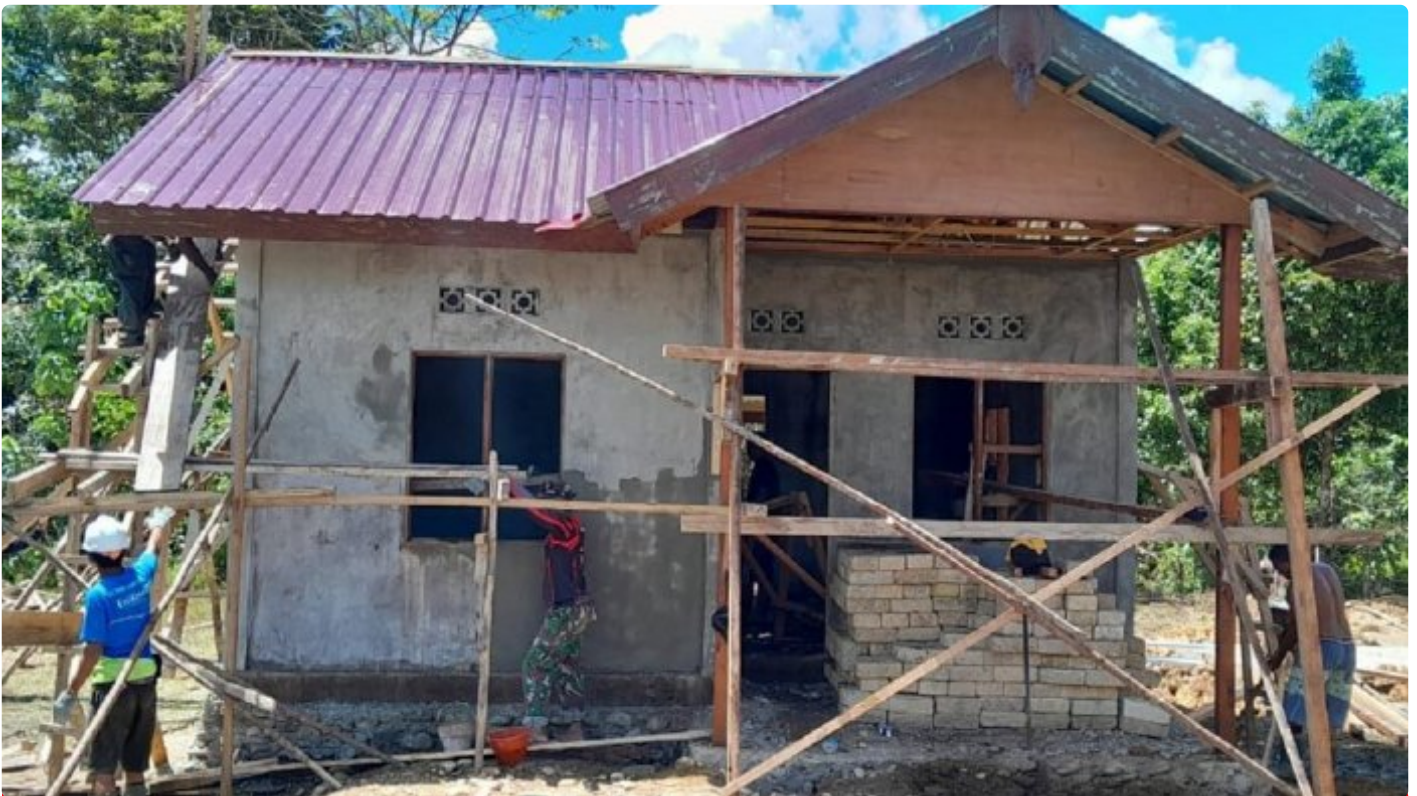
Terlihat bangunan Rumah Pastori Tipe 36 Yang Sudah Rampung 78 Persen
